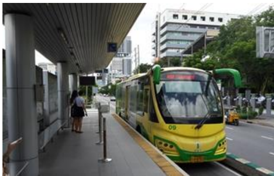
61 pav. BRT stotelės platforma Bankoke, Tailande
