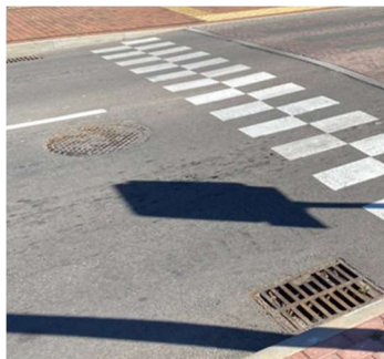
pav. 7.4 Iškilųjų pėsčiųjų perėjų schemas ir pavyzdys (su lietaus vandens nuleidimo sprendiniais)
