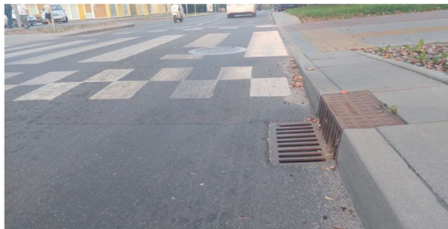
pav. 7.4 Iškilųjų pėsčiųjų perėjų schemas ir pavyzdys (su lietaus vandens nuleidimo sprendiniais)
