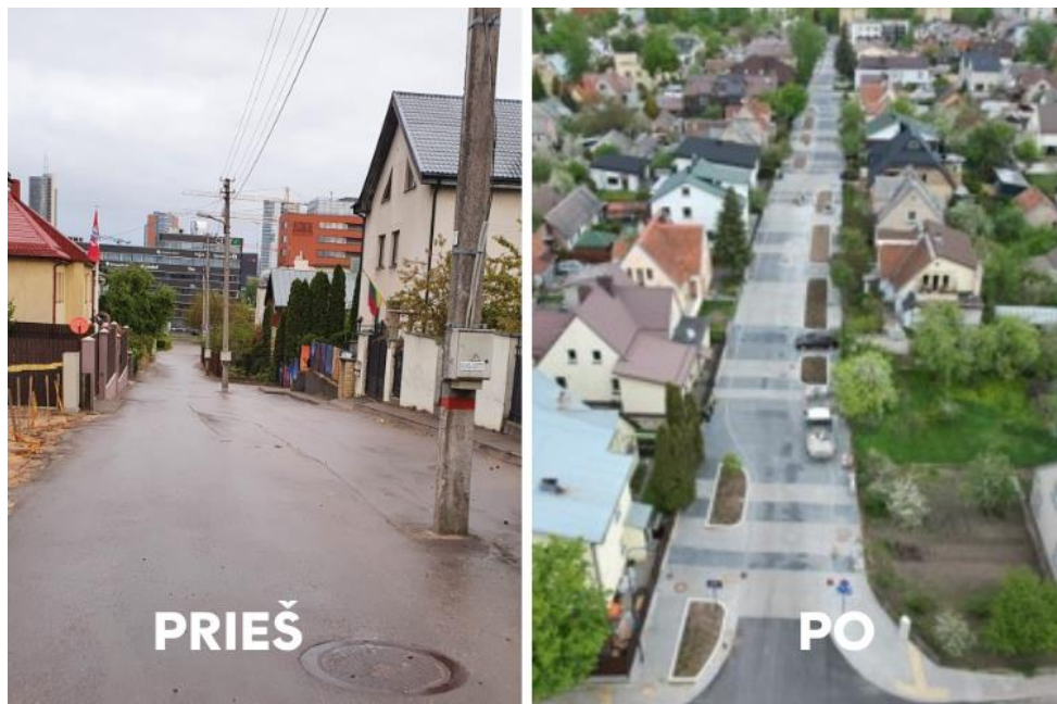
pav. 8.8 Širvintų gatvė, Vilnius Šaltinis: https://judu.lt/gatviu-modernizacija/sirvintu-gatve/
